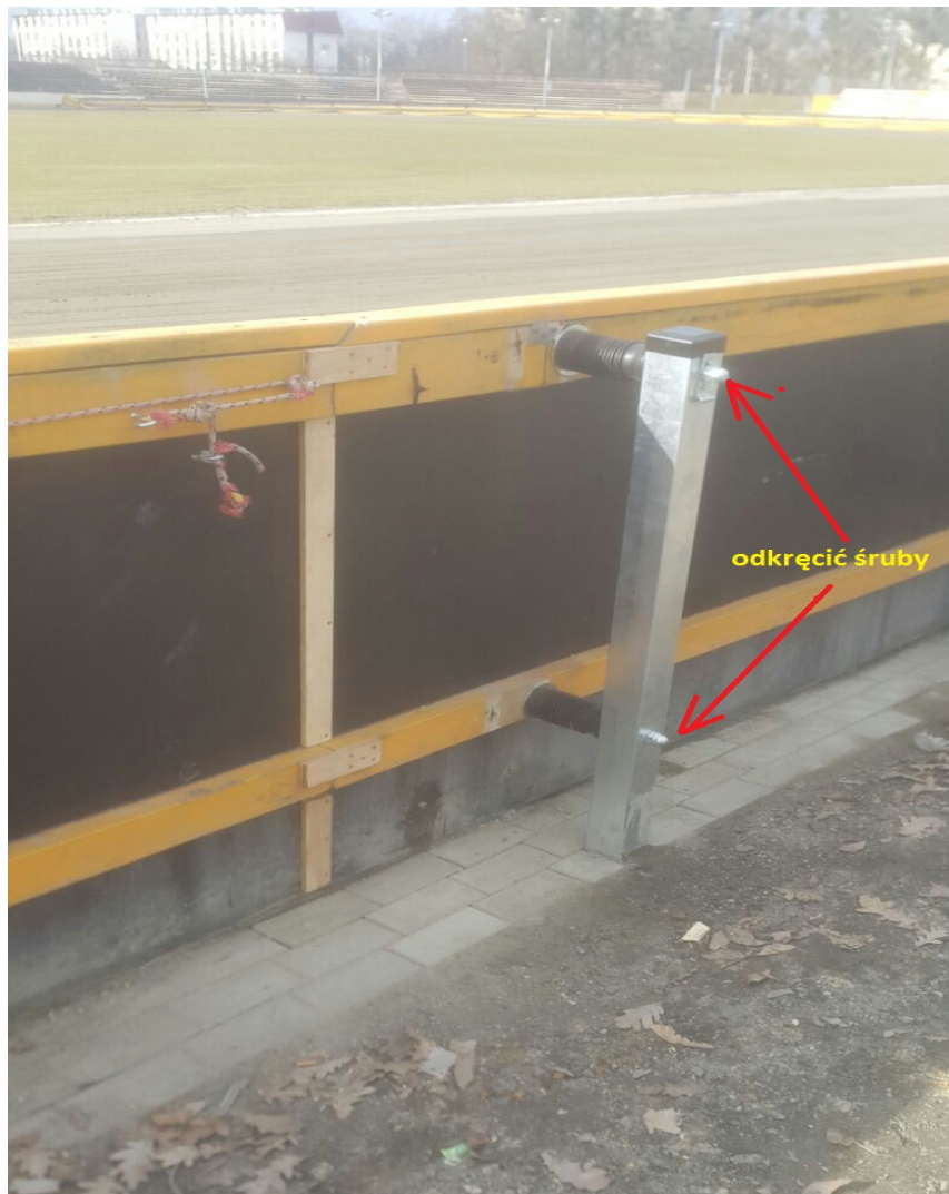
rys. 1. Śruby do odkręcenia w przypadku wymiany modułu
