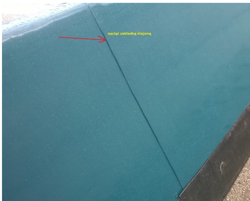
rys. 3. Miejsce nacięcia w przypadku wymiany całego elementu
