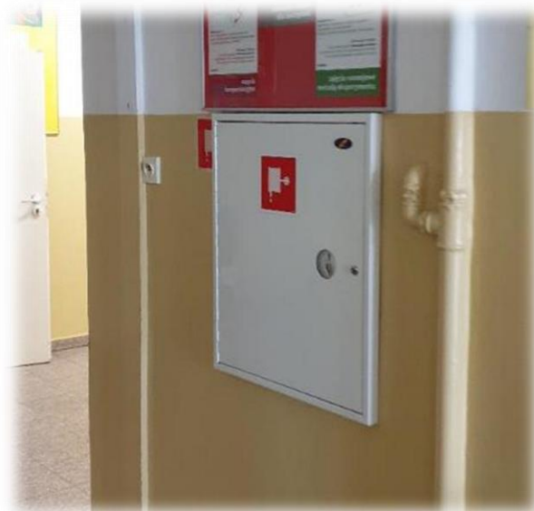
Rysunek 8. Widok hydrantu wewnętrznego
