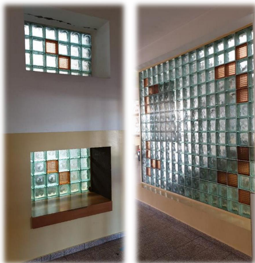
Rysunek 7. Widok luksferów bez wymaganej klasy EI120.
