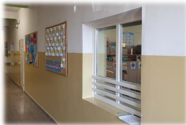
Rysunek 6. Widok okna bez wymaganej klasy co najmniej EI15
