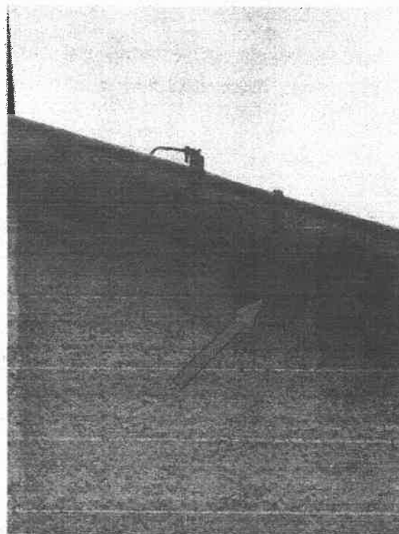
Fot. 2-3. Szczelina pod tynkiem oraz jeden z otwartych otworów prowadzących do stropodachu.
