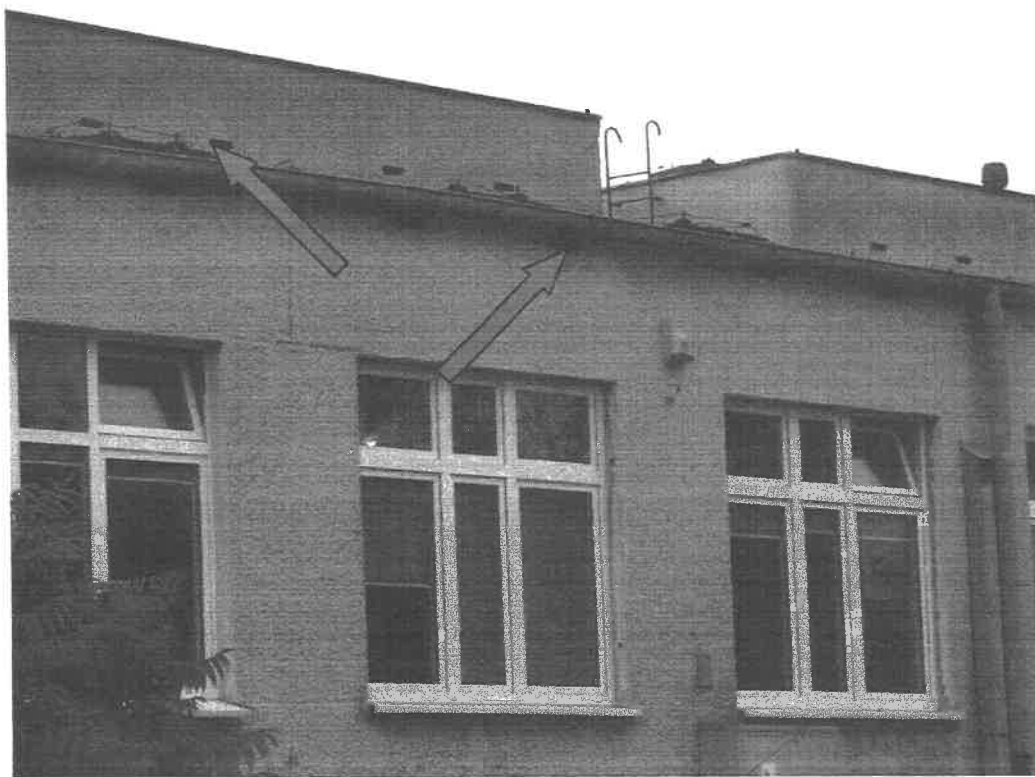
Fot. 1. Ściana frontowa budynku z zaznaczonymi przykładami wlotów.
