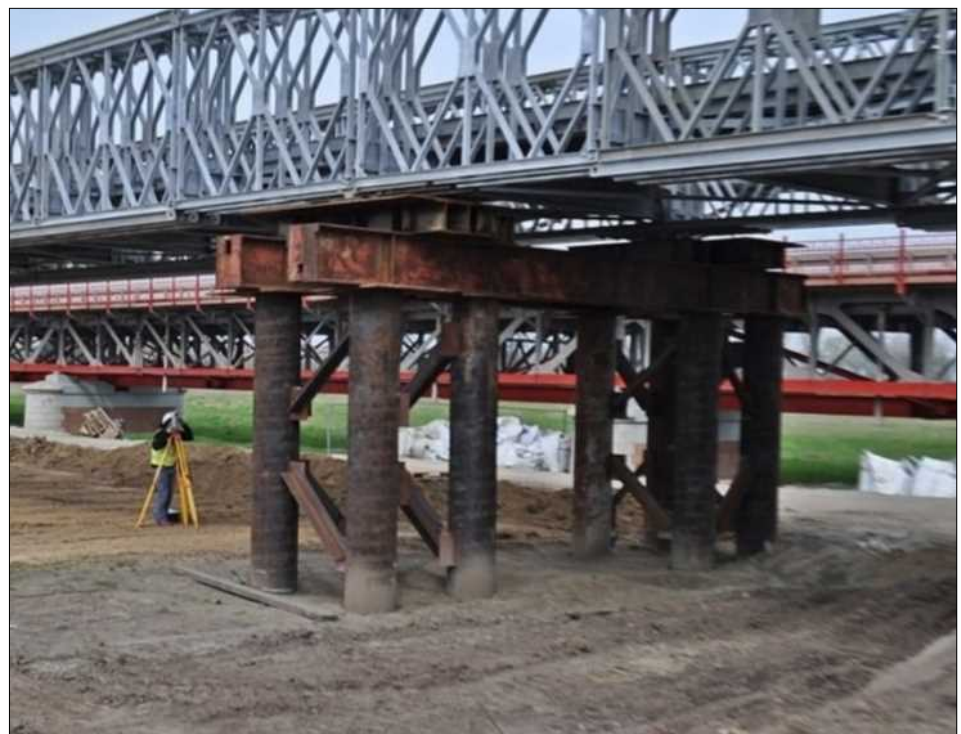
Fot.2 Przykład zastosowanej podpory tymczasowej na terenie zalewowym.
