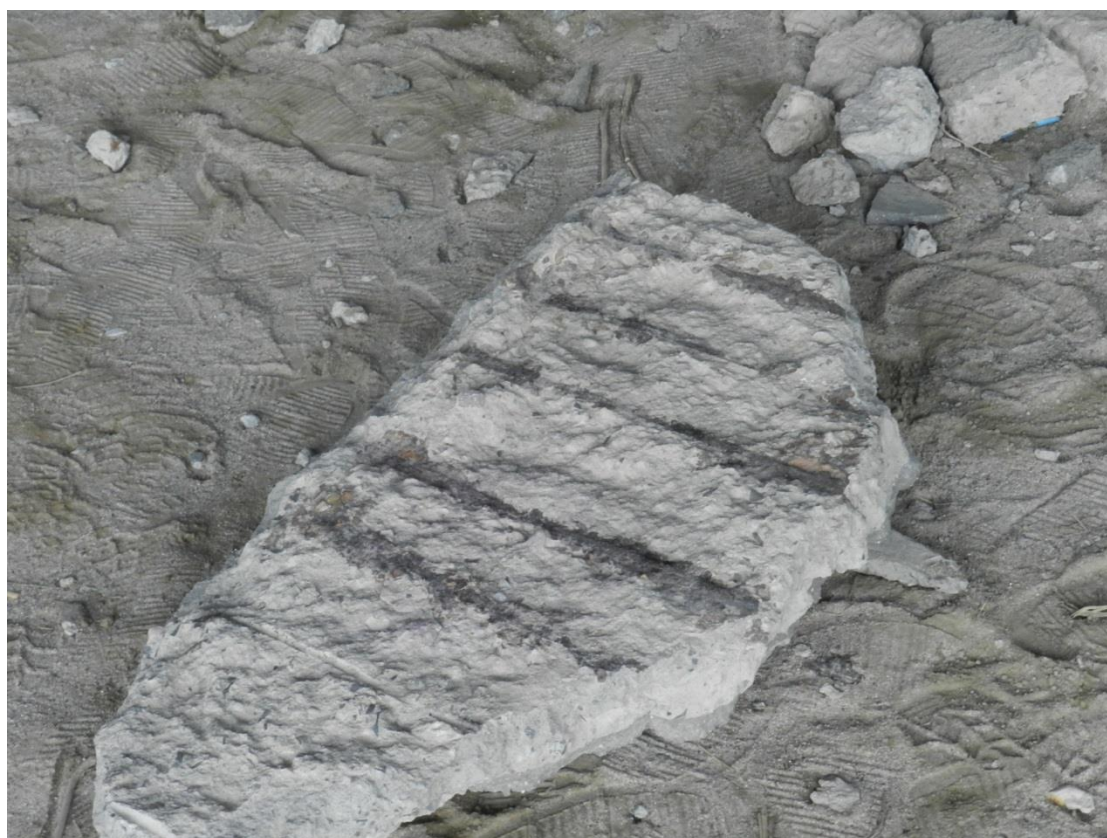
Fot. 6 Odspojony fragment otuliny – widoczne rdzawe odciski zbrojenia
