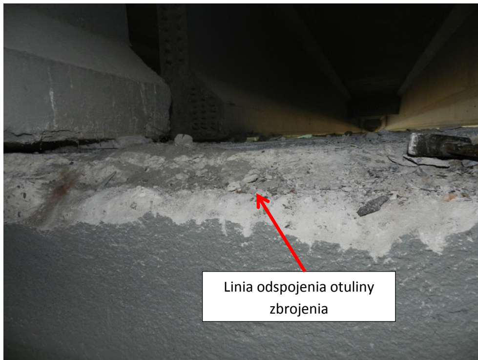
Fot. 3 Odspojenie otuliny na górnej krawędzi rygla
