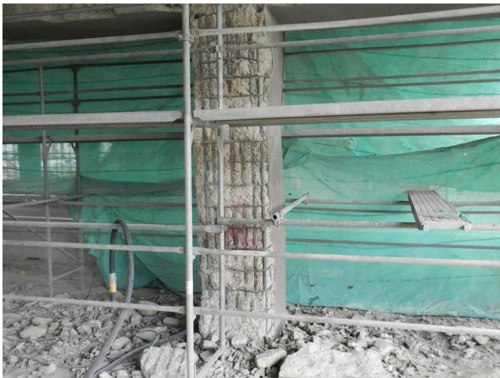
Fot. 1 Odślonięte, korodujące zbrojenie – noga ramy, przygotowanie do wykonania naprawy
