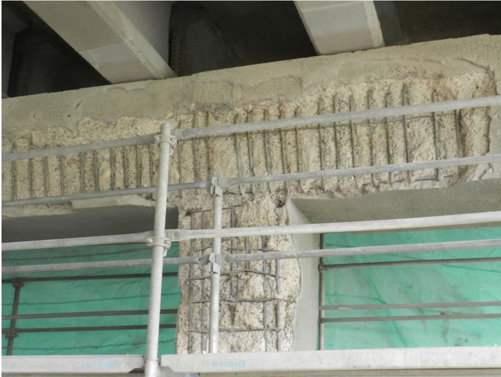
Fot. 2 Odślonięte, korodujące zbrojenie – połączenie nogi ramy z rygłem
